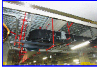
ベルトコンベアが自動的に作動し、屋内駐車場を通過して、施設内へと運ばれていきます。
